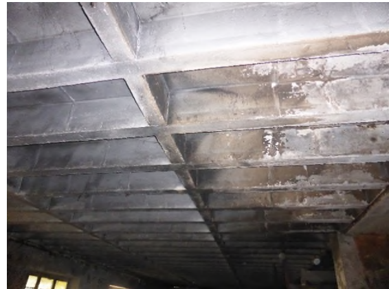
Abbildung 7b: Rippendecke [Walter Reif Ing. GmbH]
