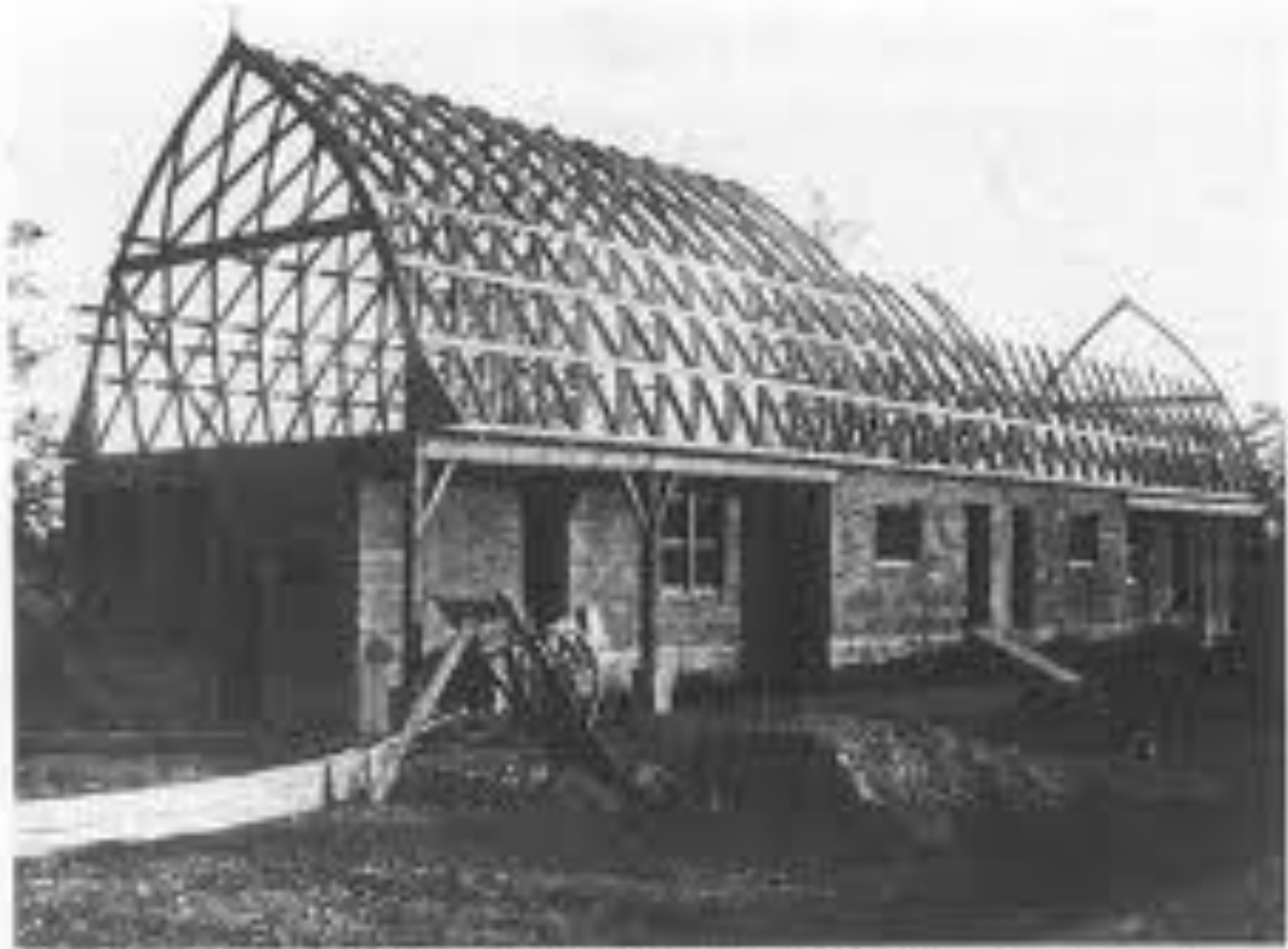
Bild 4. Doppelhaus mit Zollbau-Lamellen-Dach im Bau (Genssler Straße, Merseburg 1922)
