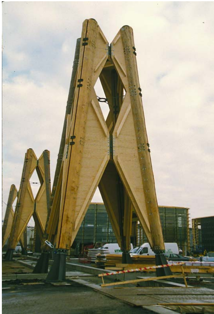
Abb. 9 Ansicht des Turmes
