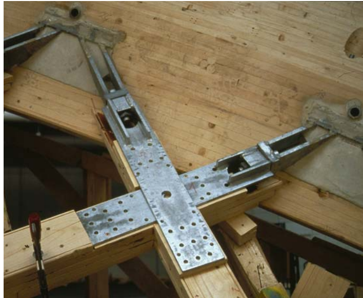
Abb. 5 Rippenanschluss an Kastenträger
