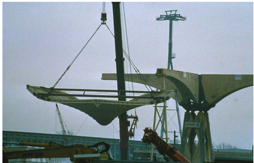
Abb.11 Einheben einer Rippenschale
