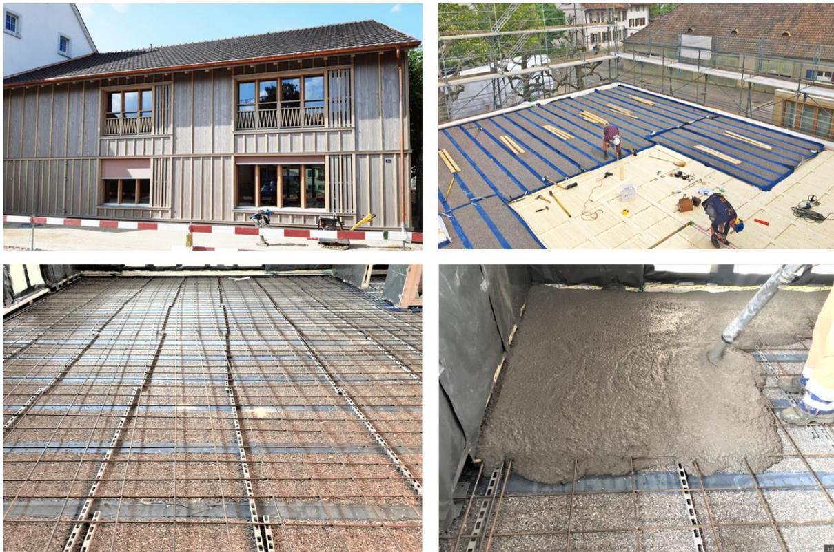
Abbildung 8: oben: Doppelkindergarten Sissach, I.: Ansicht r.: Holzlage der HBV-Decke © Beer Holzbau AG
