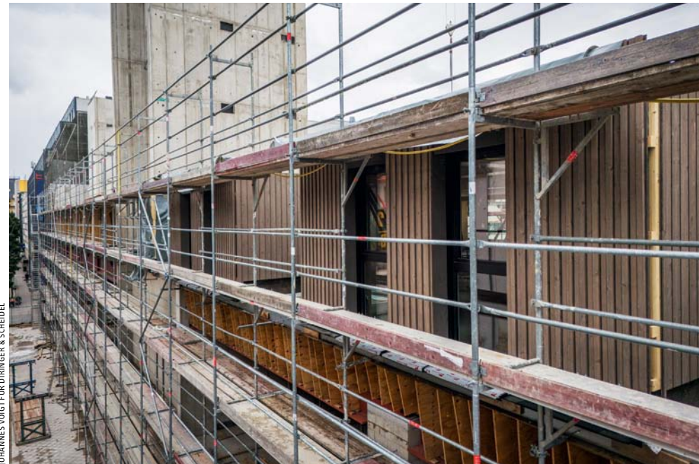
▲ Während die ersten Stockwerke und Untergeschosse des alten Gebäudes bestehen blieben, wächst ab dem zweiten Obergeschoss eine Holz-Hybrid-Struktur in die Höhe, ein Novum in der Region
