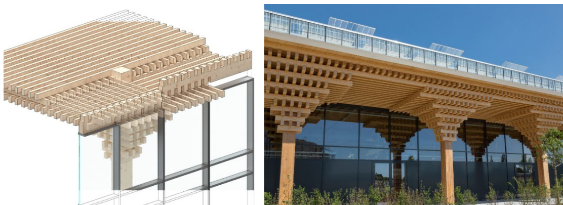
Abbildung 12: Anschluss der Fassade an den Fassadenträger (@knippershelbig)
