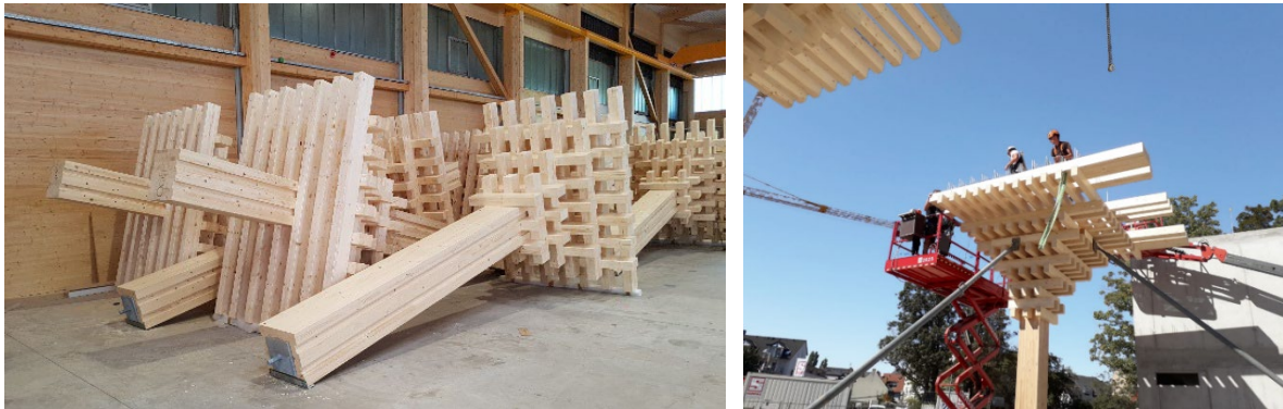
Abbildung 10: links: Vorfertigung, rechts: Vormontage (©Holzbau Amann)
