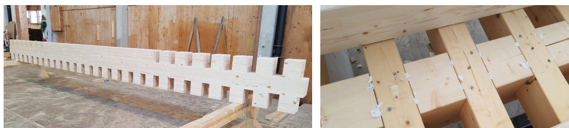
Bild 13: Fertigung/Montage des Fassadenbalkens (©Holzbau Amann)
