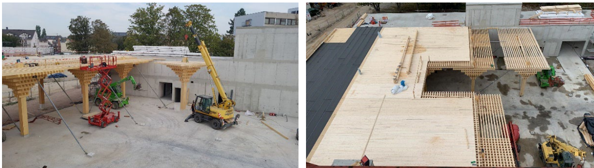
Abbildung 11: links Einhub, rechts Verschraubung der Balkenlagen und Dachabdichtung (©Holzbau Amann)
