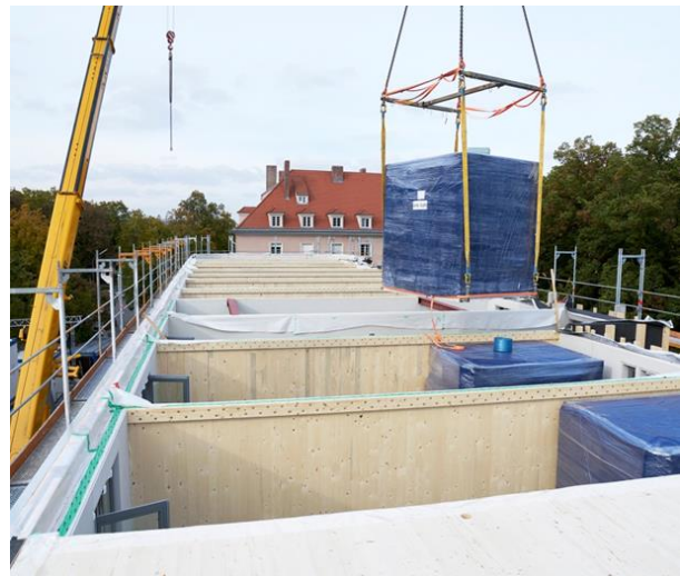
Abbildung 7: Montage von Sanitärmodulen
