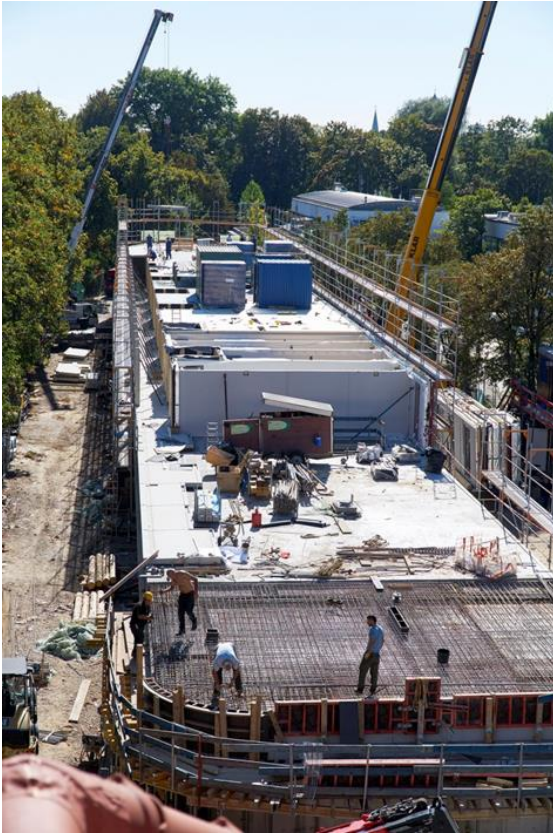
Abbildung 8: Enge Taktung von Beton- und Holzbau
