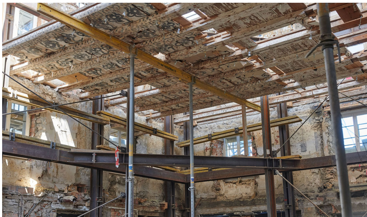
Abbildung 4: im Bauzustand stabilisierte Balkenlage mit historischen Malereien
