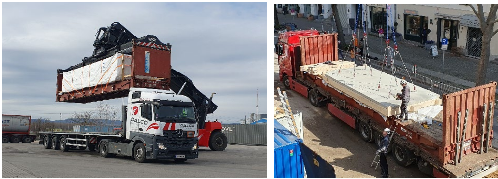
Abbildung 13: Transport der fertigen Deckenelemente zur Baustelle
