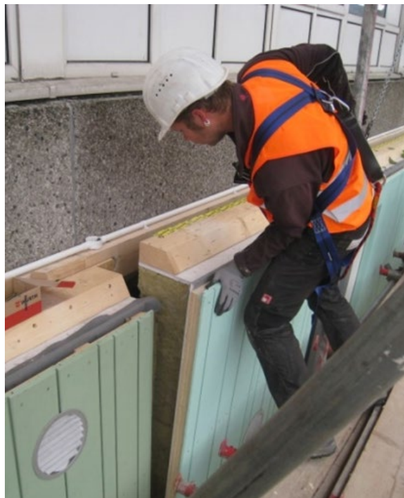
Abbildung. 9: horizontaler Elementstoß
