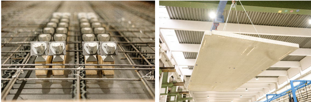
Abbildung 10: links: Fertigung Beton-Fertigteilplatten (Einbau FT-Verbinder und Bewehrung im Schalbett) rechts: Fertigung der Decken-Holzrahmen (Quelle: OBERNDORFER Hybrid Systems GmbH)
