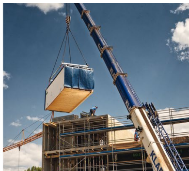
Modulmontage vor Ort
