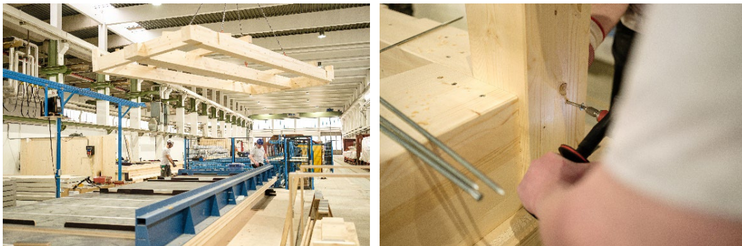
Abbildung 11: Zusammenführen von Beton-Fertigteilplatte und Decken-Holzrahmen links: vorgefertigter Holzrahmen rechts: vorgefertigte Betonplatte mit einbetonierten FT-Verbindern (Quelle: OBERNDORFER Hybrid Systems GmbH)
