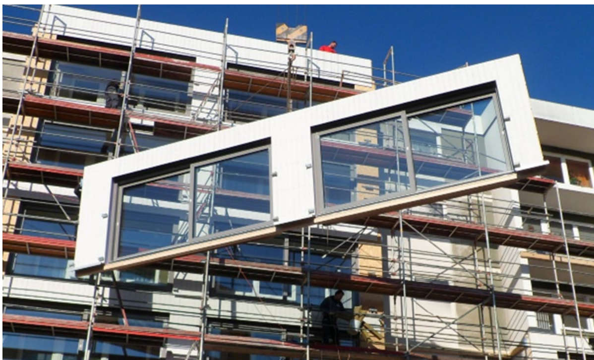
Abbildung 5: Montage TES Element
