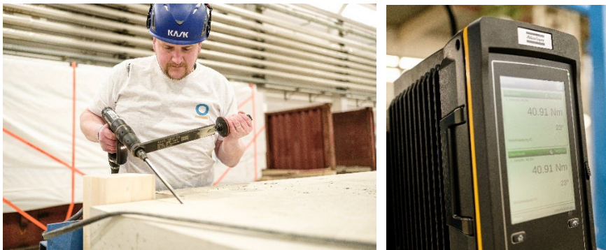
Abbildung 12: Fügen der Beton-Fertigteilplatte auf den Decken-Holzrahmen links: Einbringen der Schrauben rechts: Dokumentation der Schraubvorgänge zur Qualitätssicherung (Quelle: OBERNDORFER Hybrid Systems GmbH)
