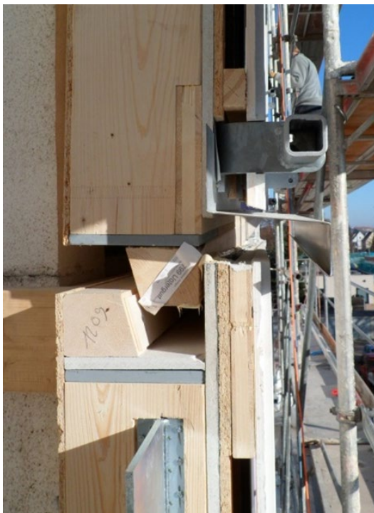
Abbildung 8: vertikaler Elementstoß
