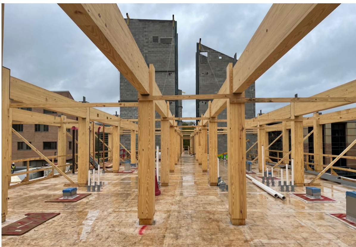
Abbildung 8: Foto Baustelle, CLT Stützen und Träger, Kerne aus Mauerwerk (CMU Blocks)
