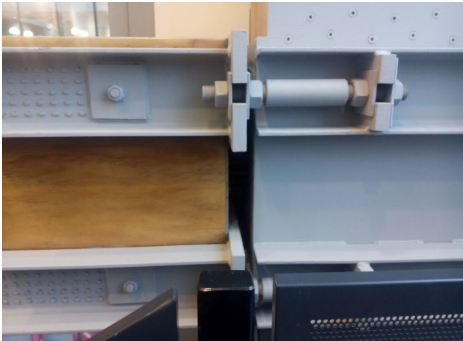
Abbildung 3: Dissipative Gewindestange im Trimble Navigations Hauptsitz, Ōtautahi Christchurch, Aotearoa Neuseeland.
