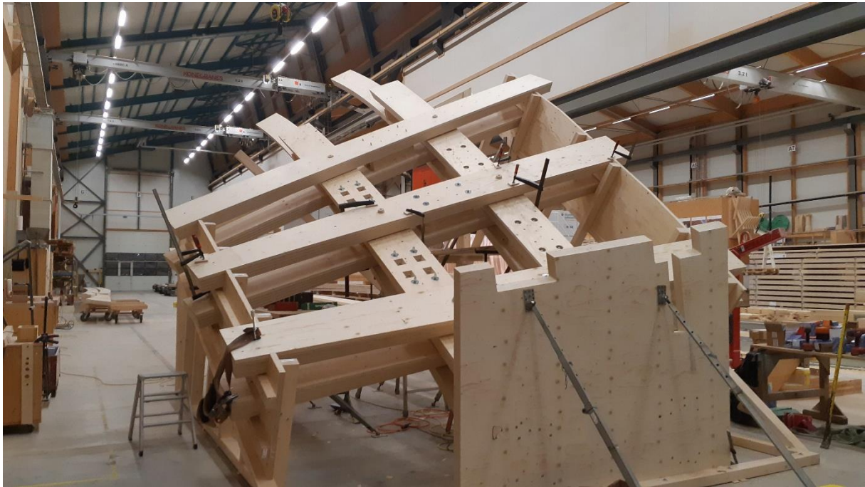
Abbildung 5: 1:1 Mock-up der Dachkonstruktion für den Wisdome in Stockholm.
