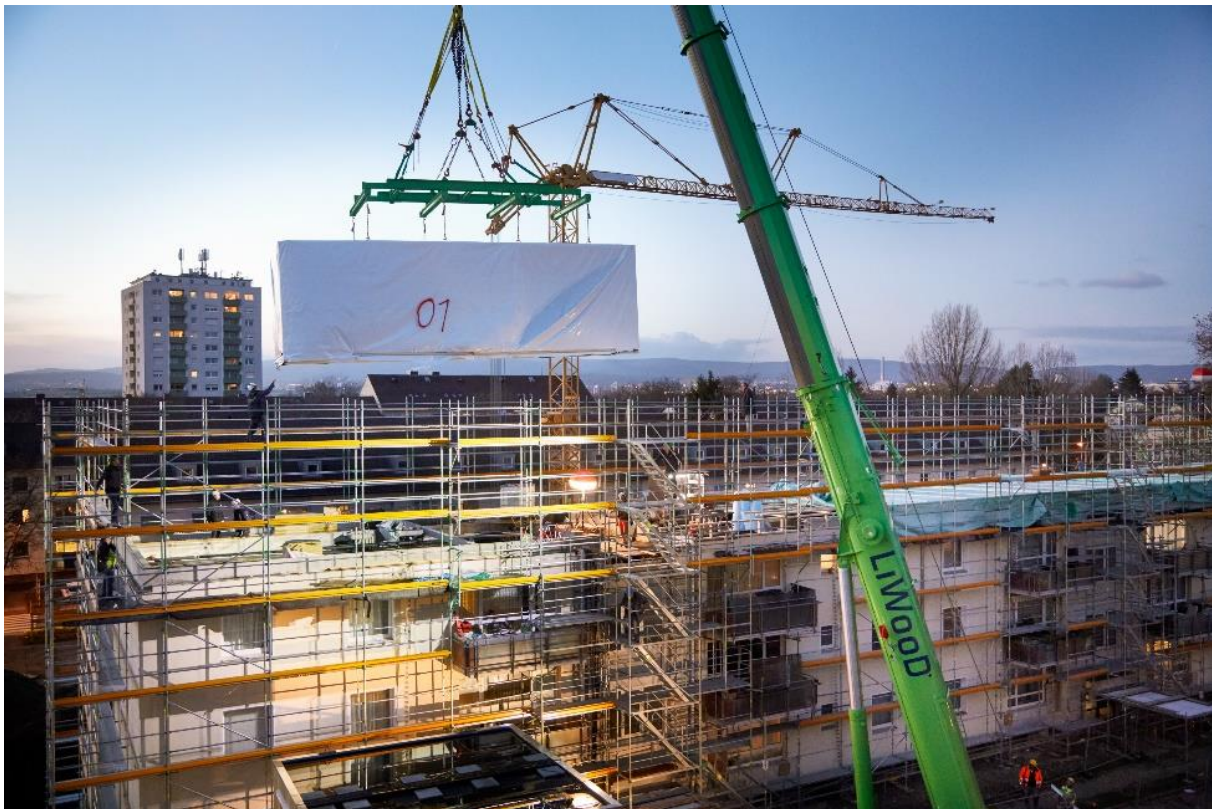
Abbildung 13: Versetzen des ersten Moduls von insgesamt 1.102
