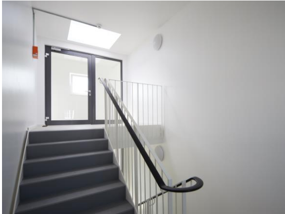
Abbildung 17: Treppenhaus komplett aus Holz in Gebäudeklasse 5 (Treppenlauf aus A-Baustoffen)
