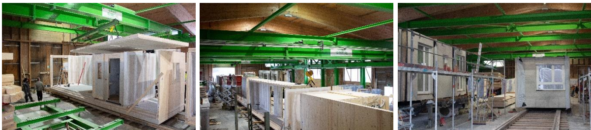
Abbildung 10, 11, 12: Modulmontage in der Feldfabrik
