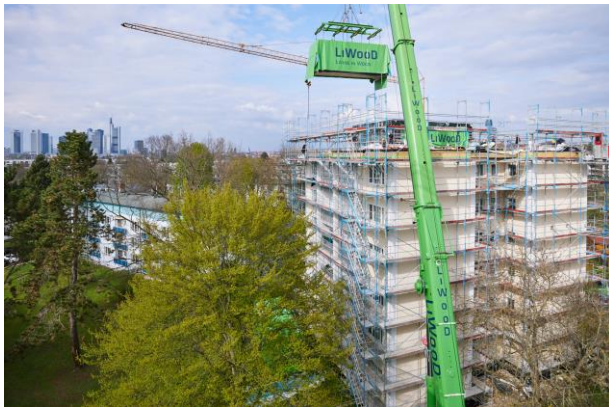
Abbildung 16: Modulmontage im 8. Geschoss
