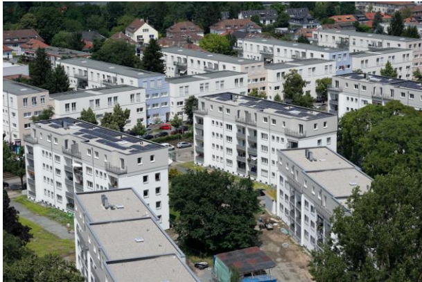
Abbildung 14: Blick auf die fertiggestellte eingeschossige Aufstockung
