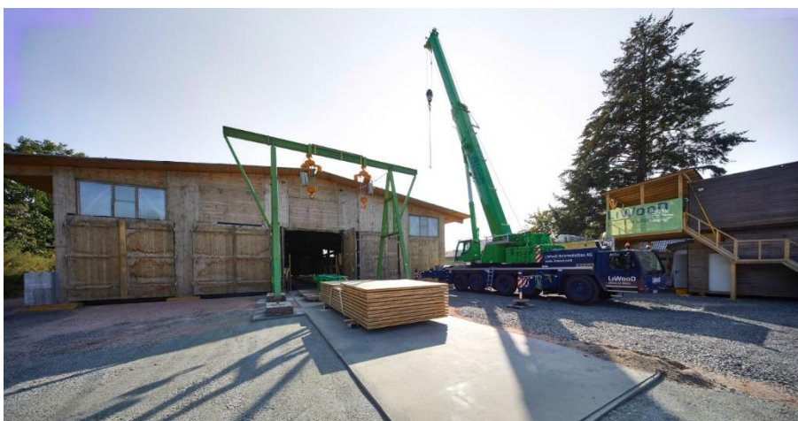
Abbildung 9: Die Feldfabrik – eine mobile Montagehalle aus massivem Holz
