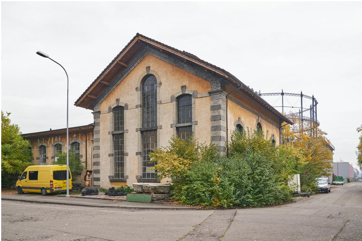
Das ehemalige Gaswerk in Schlieren
