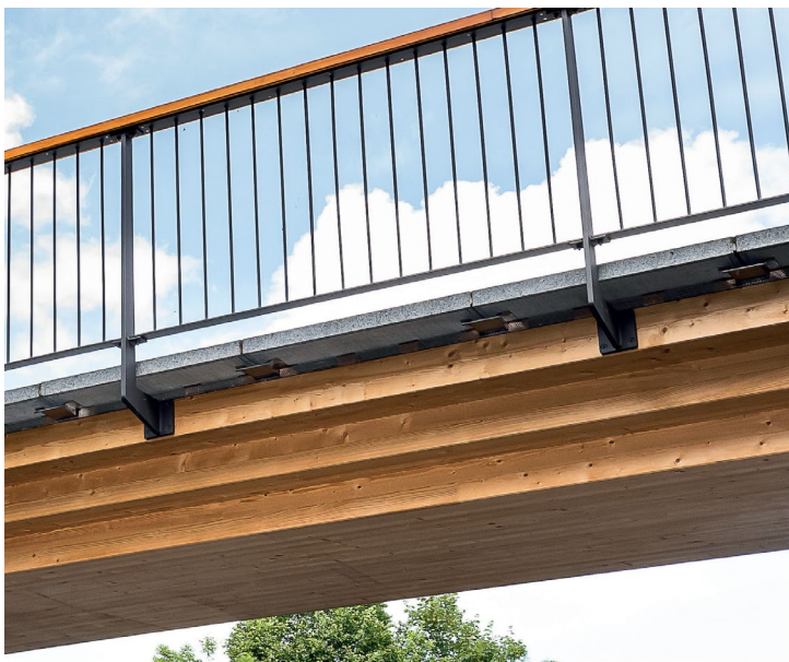
Abbildung 3: Geländeranschluss: durch Vollgewindeschrauben erfolgt die Verbindung – sowohl druck- und zugfest
