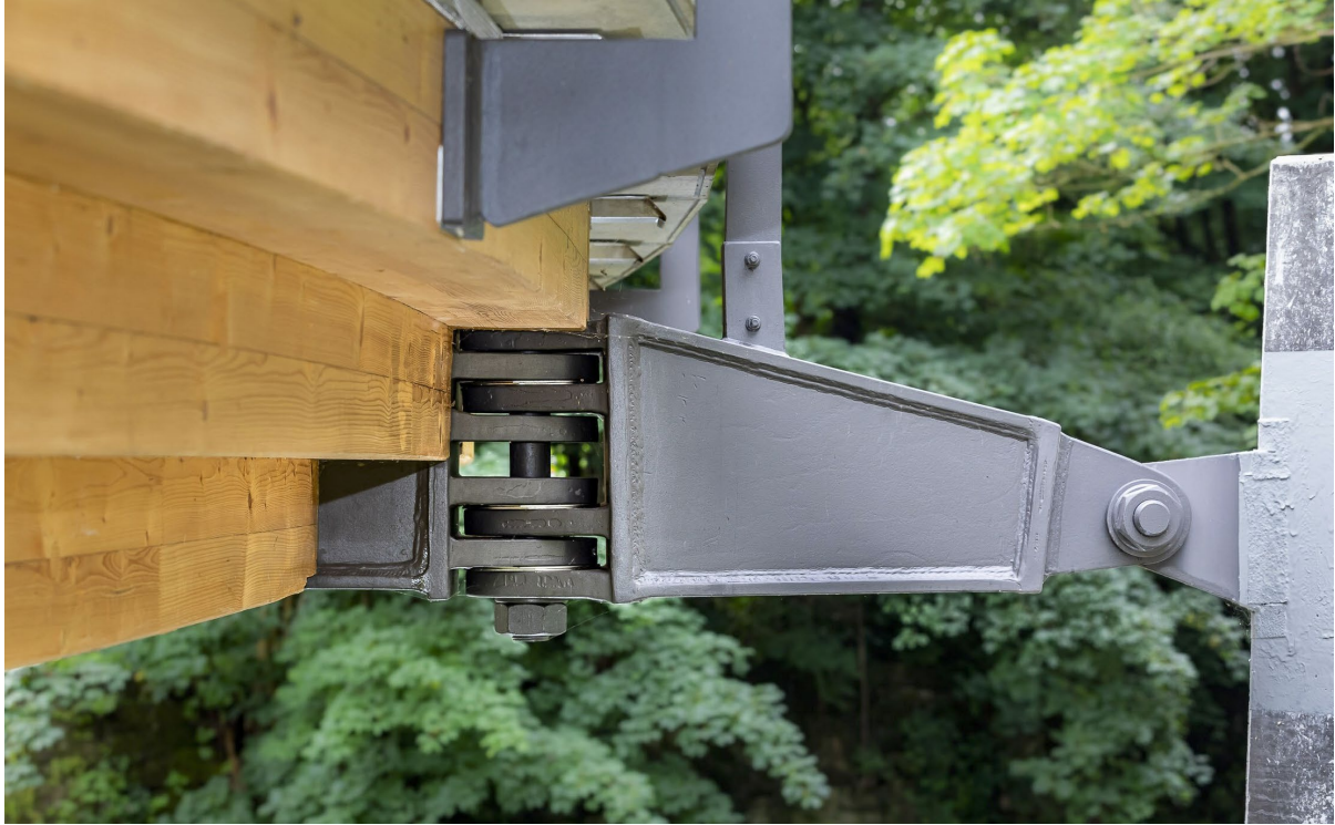
Abbildung 6: Anschluss Brückenträger zum Stahlmast ermöglicht zwängungsfreie Verdrehung
