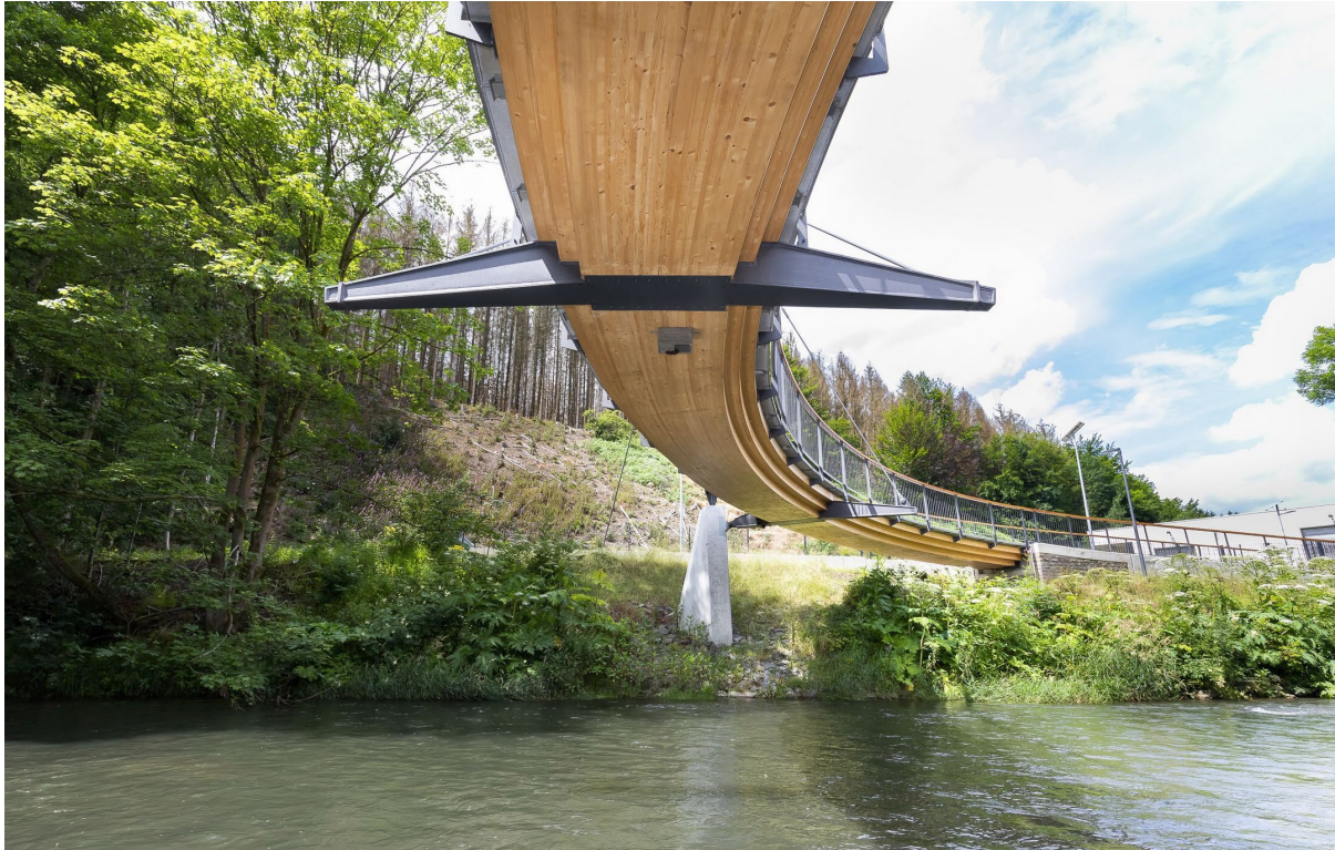
Abbildung 2: Brückenuntersicht mit getrepptem BSH-Träger (mittig: Vogelkasten)
