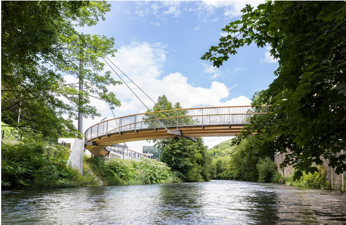
Abbildung 1: Viertelkreisförmig geschwungene Holzbrücke mit Schrägseilabspannung
