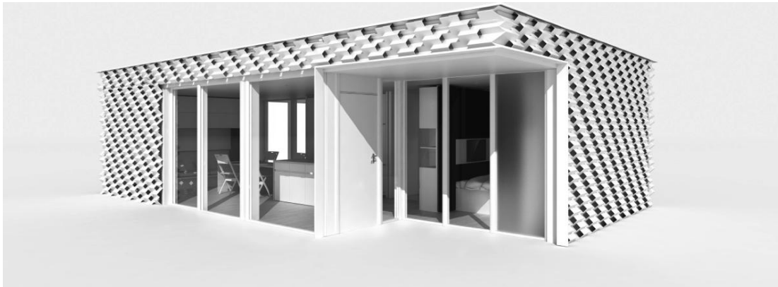
Abbildung 3: Visualisierung des Rosenheimer Hauses. Die „Zacken“-Fassade als variabler Sonnenschutz ist eine Eigenentwicklung der HS Rosenheim
