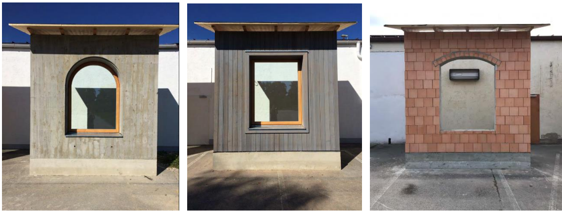
Abbildung 6: An drei 1:1 Modellen wurden exemplarische Details (Sockel, Öffnungen) und materialgerechtes Konstruieren erprobt. Foto: TUM
