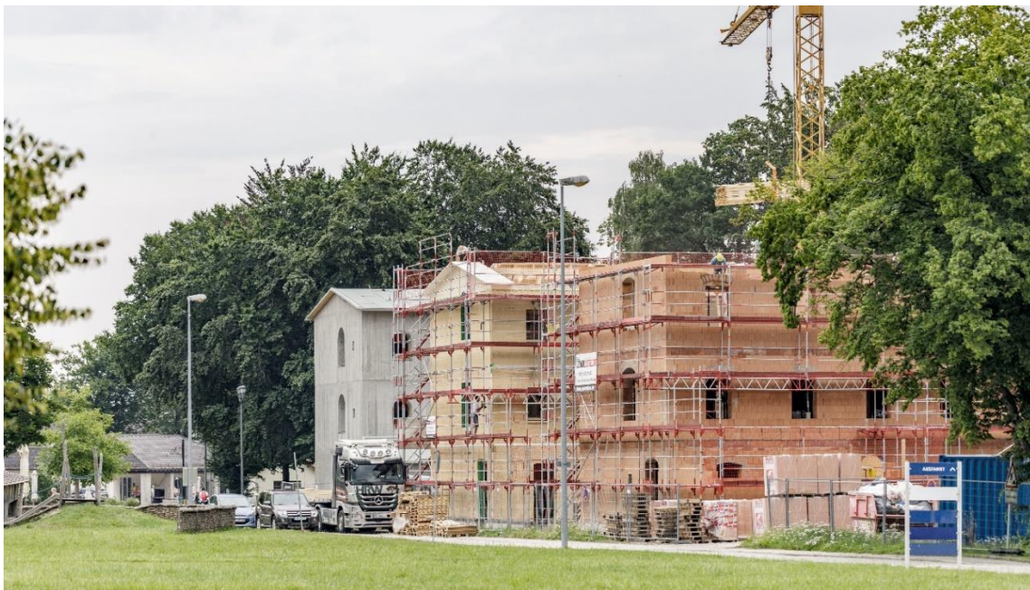
Abbildung 7: Straßenansicht der drei Forschungshäuser im Bauzustand; Foto: Max Kratzer
