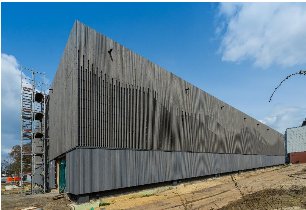
Abbildung 9: Außenansicht der Sporthallenfassade mit versetzter Leistenschalung in Wellenform kurz vor der Fertigstellung
