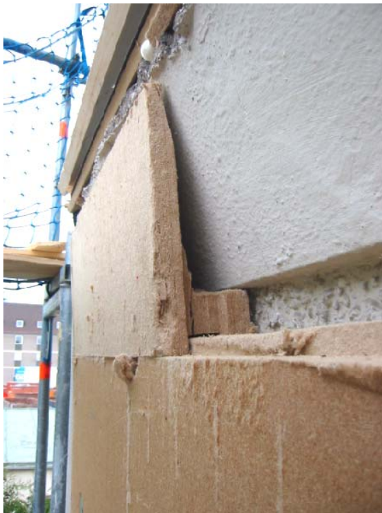
Abbildung 2: Beispiele mangelhafter Bauausführung in Projekten der Landeshauptstadt München
