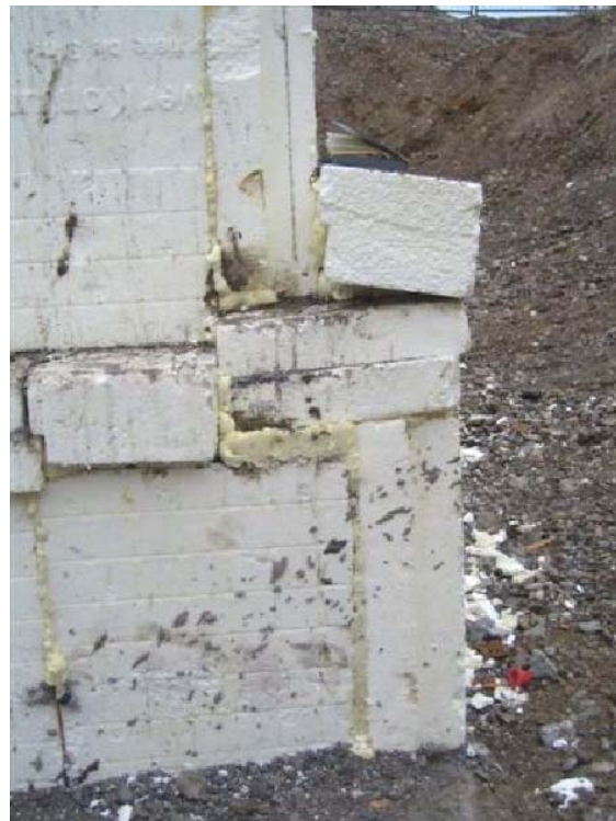
Abbildung 2: Beispiele mangelhafter Bauausführung in Projekten der Landeshauptstadt München
