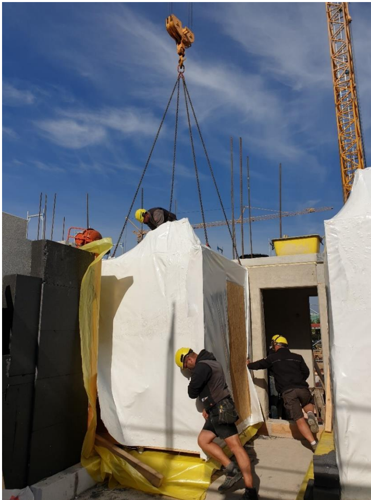
Abbildung 16: Montage Badmodul, Atelier PK Architekten
