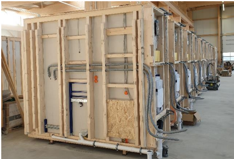
Abbildung 11: Badmodule in Vorproduktion, Gebr. Schütt KG (GmbH & Co.)
