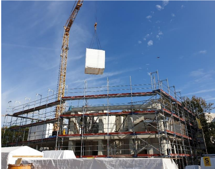
Abbildung 15: Montage Badmodul, Atelier PK Architekten
