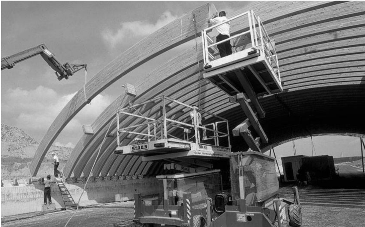
Abb. 5: Montage der Brettschichtbinder, hier noch Wilmschagen
