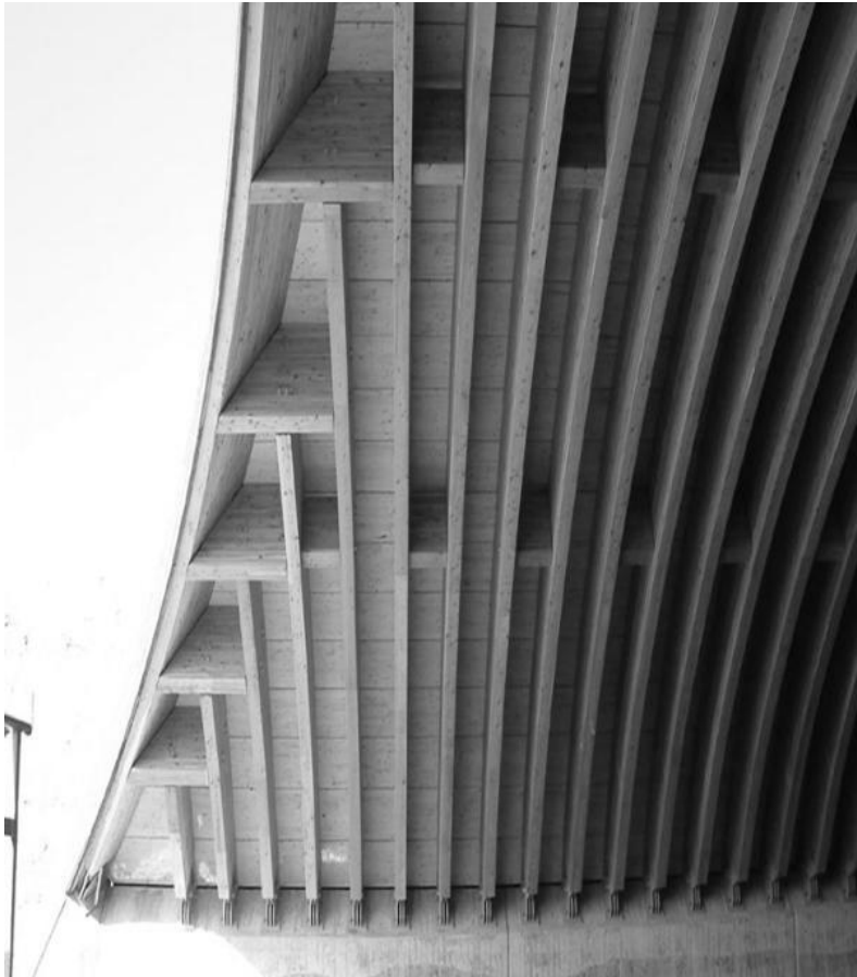
Abb. 10: Optimierungsansätze für Grünbrücken in Holzbauweise
