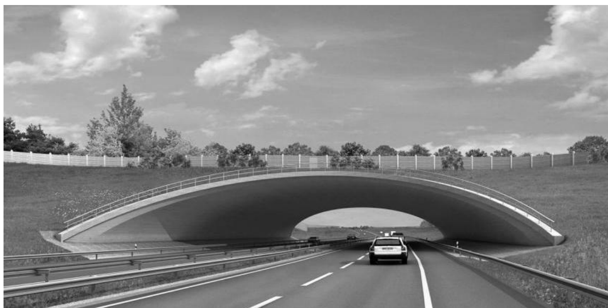
Abb. 9: Grünbrücke ZORGES an der A 143 bei Halle Vorzugslösung wegen setzungsempfindlicher Gründung im Altbergbauegebiet
