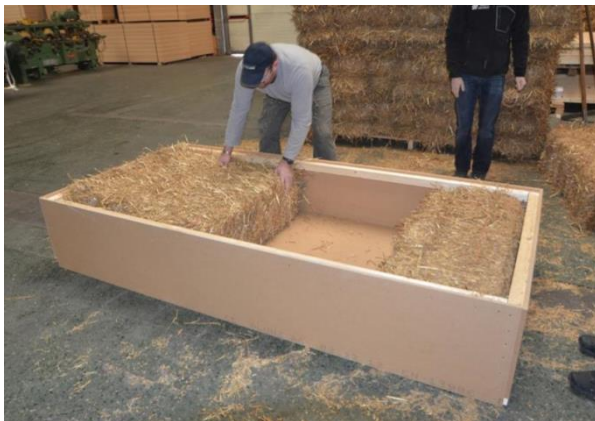
Bild 27: Vorfertigung der Isolierung
