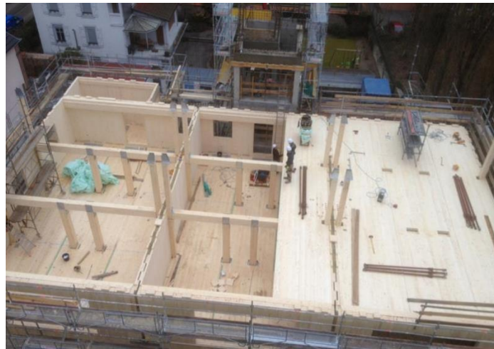
Bild 26: Tragkonstruktion während der Montage
