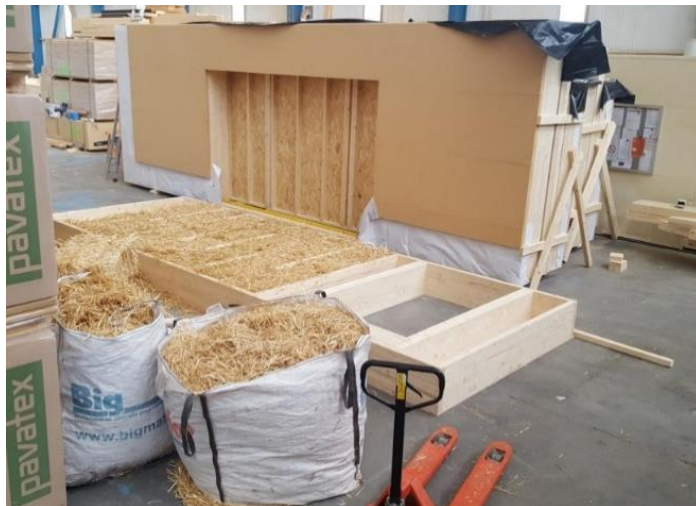
Bild 18: Vorfertigung der Wände
