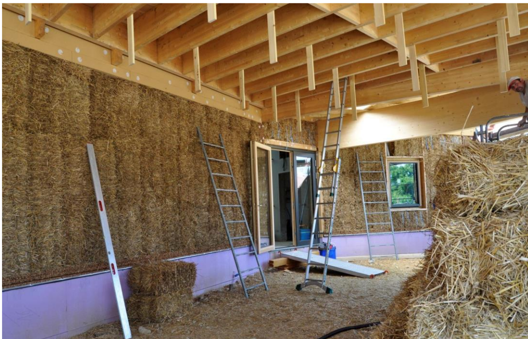
Bild 24: Innenansicht im Bauzustand
