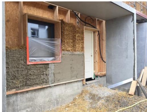
Bild 15: Aufbringen der verschiedenen Putzschichten
