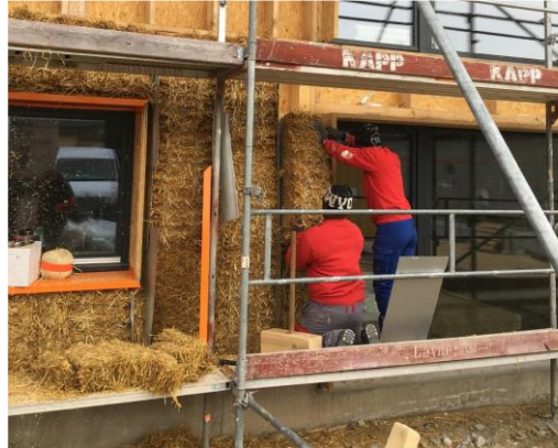
Bild 13: Einbau der Strohballen
