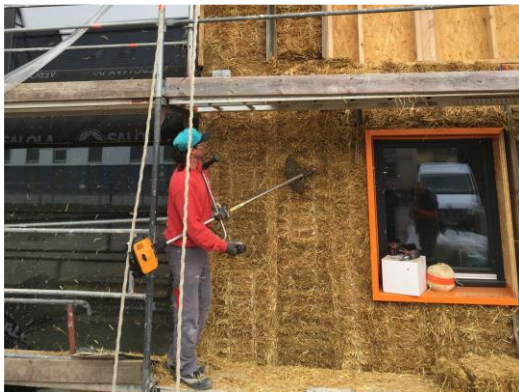
Bild 14: Glätten der Fassade (Abschneiden überstehender Halme)
