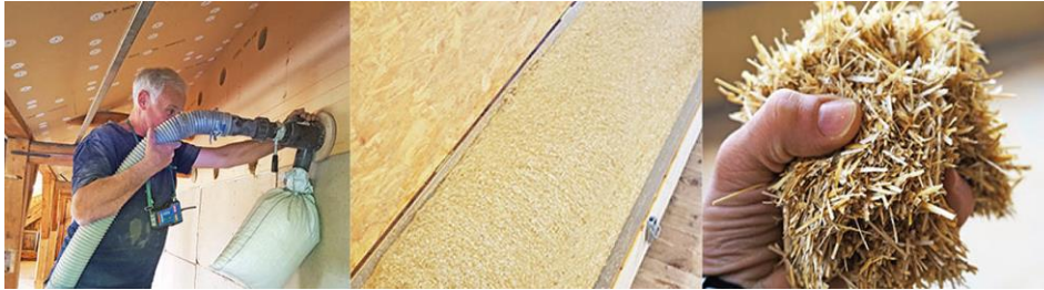
Bild 1: Einblasdämmung
