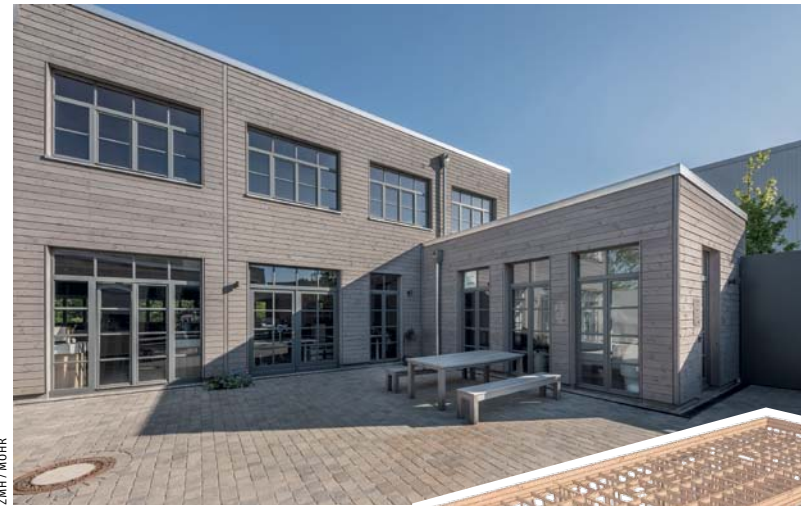
◀ Neben dem zweigeschossigen Neubau in Holzrahmenbauweise stand die Sanierung der alten Gewerbehalle auf der Agenda
