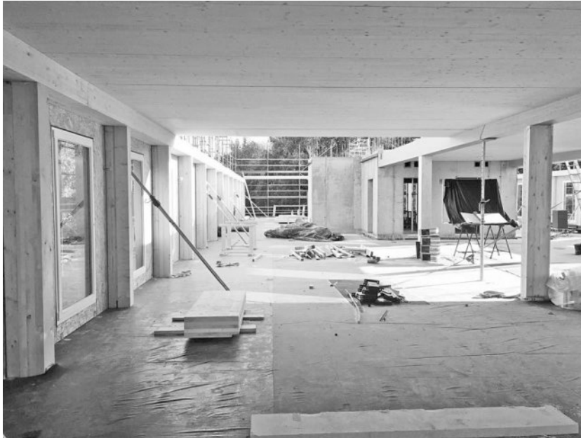
Abbildung 2: Rohbau mit Skelett aus Stützen und Trägern.
