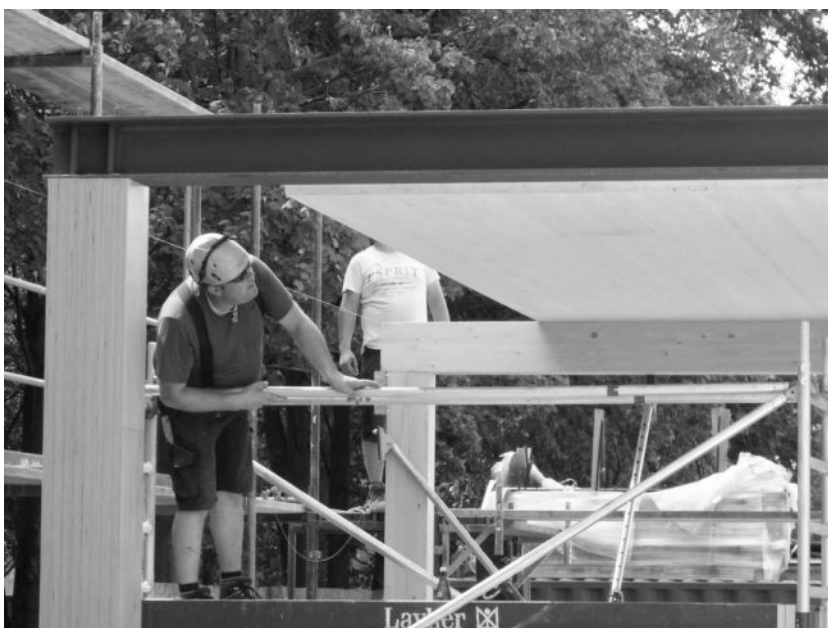
Abbildung 3: Montage der Deckenelement auf den Unterzügen
