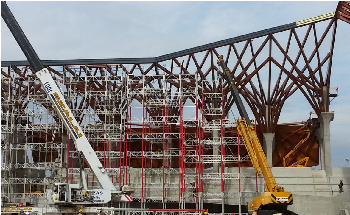
Einrüstung des Daches
