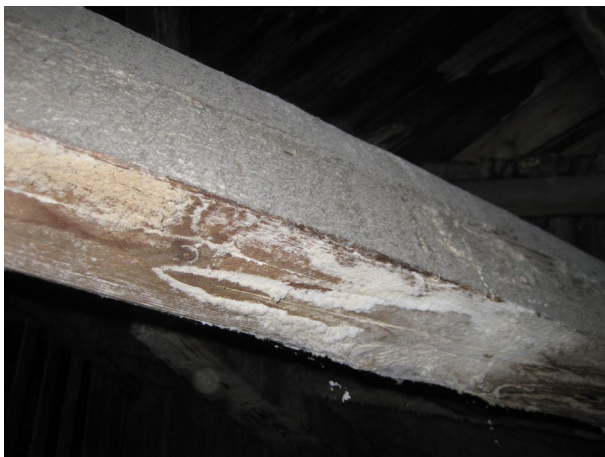
Abbildung 1: Historische Anpassung an den Stand der Technik als Herausforderung im heutigen Re-Use: Im Zweiten Weltkrieg aus Brandschutzgründen gekalkter Dachstuhl, © Holzforschung Austria
