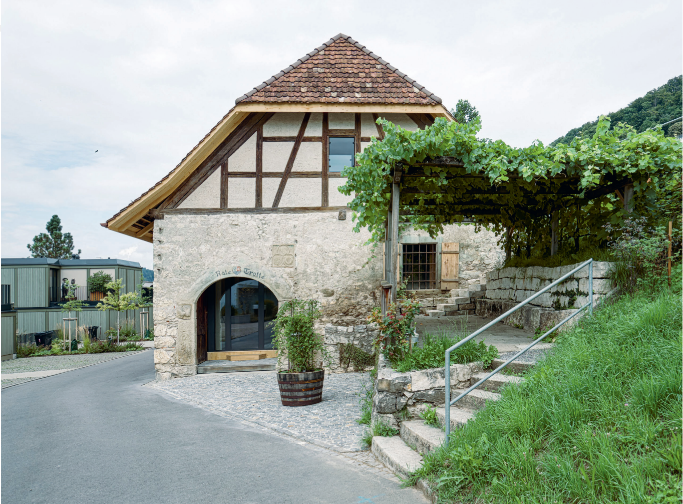
Hinter diesen dicken Mauern der Roten Trotte in Wettingen wurden früher Trauben gepresst – heute sind dort zwei Wohneinheiten eingerichtet.
