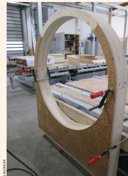
◀ Zahlreiche Arbeitsschritte waren nötig, um die Gauben anzufertigen
