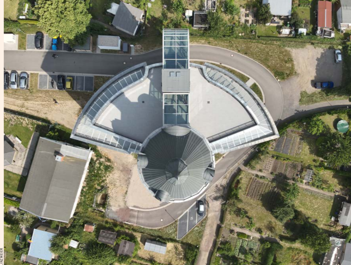
▲ Der umfassend restaurierte Wasserturm in Delitzsch wurde durch einen halbrunden Wohntrakt ergänzt, aus dem sich der Turmschaft nur auf einer Seite herauschält
