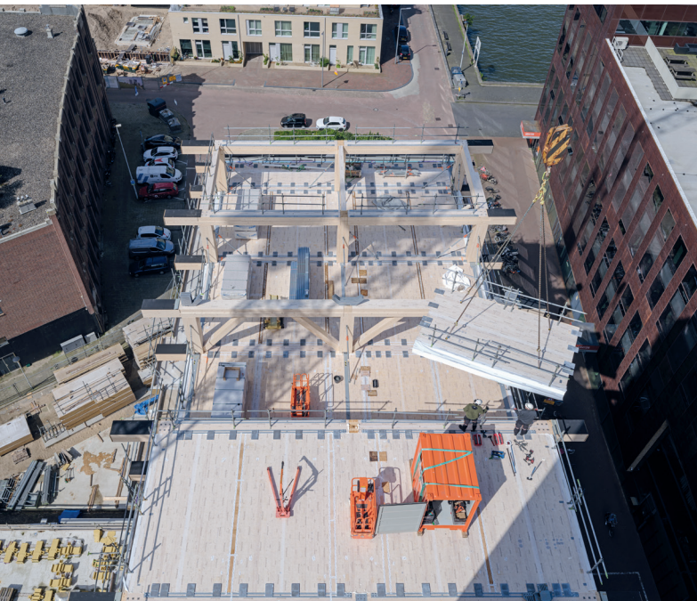
Speziell entwickelte „Galgenstützen“ ermöglichen konstruktiv die auskragenden Gebäudeteile des Projekts. Das offene Gebäudesystem erlaubt flexible Grundrisse.
