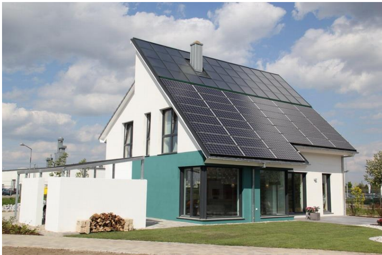
Abbildung 3: Erstes bezahlbares energieautarkes Eigenheim Europas als unbewohntes Musterhaus in Lehrte/Hannover von der HELMA Eigenheimbau AG Baujahr 2011. Es versorgt sich selbst mit Wärme, Strom und E-Mobilität: durch Solarthermie (mit Langzeitwärmespeicher), Photovoltaik (mit Akku) sowie etwas Biomasse. Primärenergiebedarf: 7 kWh/m 2 a.
