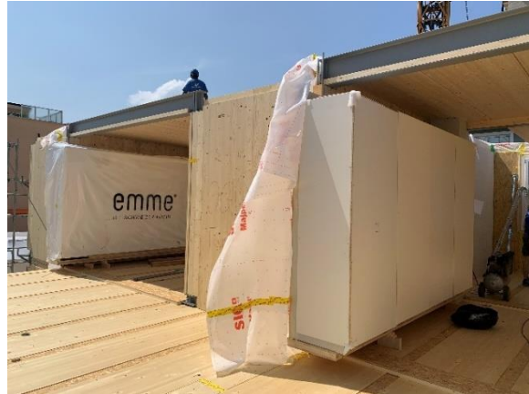
Abbildung 14: Küchen- und Badmodule mit Stahlträger
