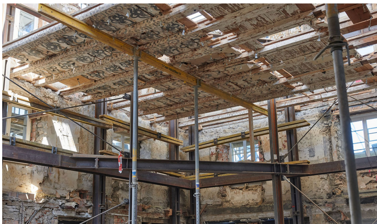
Abbildung 4: im Bauzustand stabilisierte Balkenlage mit historischen Malereien
