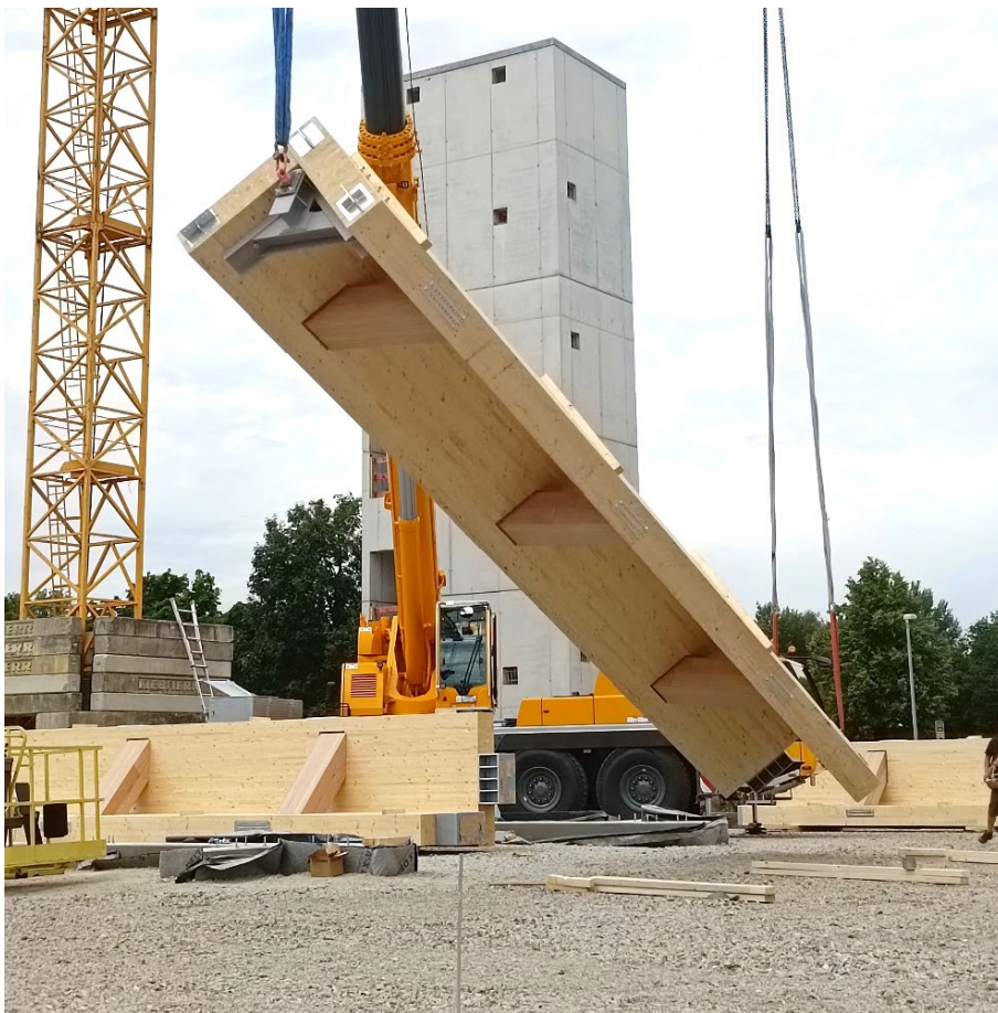
Abbildung 5: Montage einer dreigeschossigen L-Stütze
