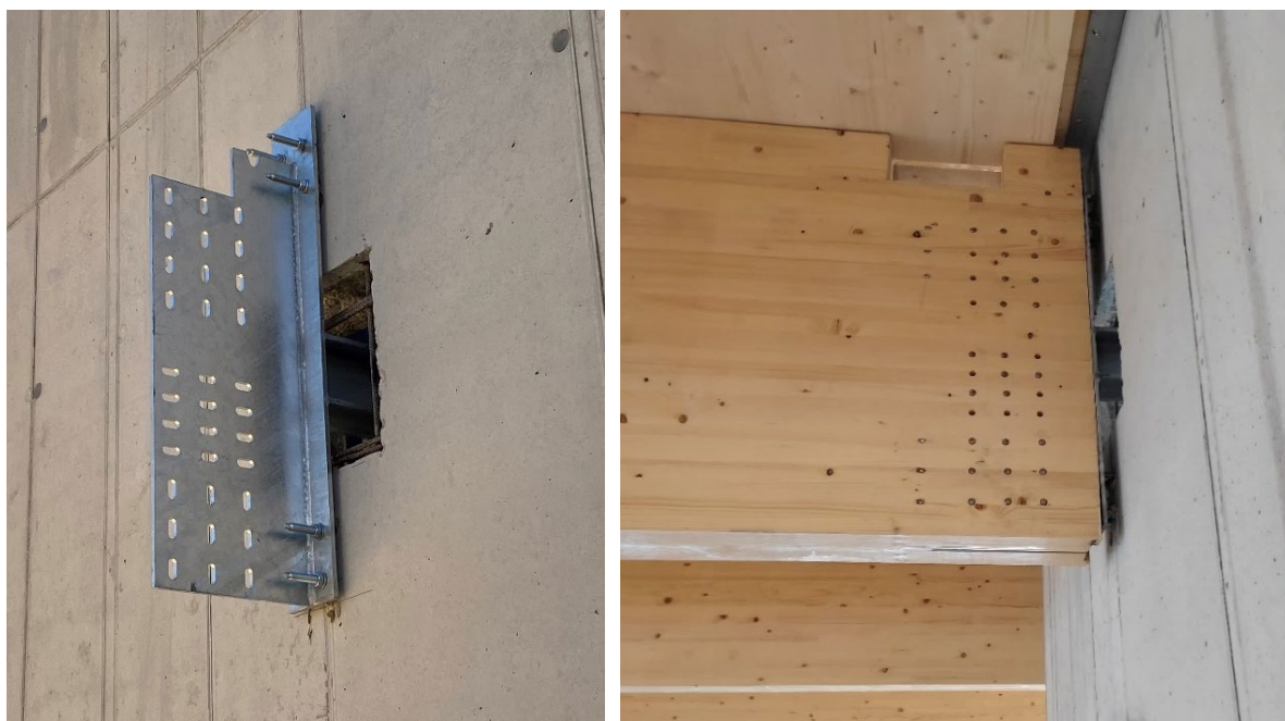
Abbildung 3: Anschluss BSH Träger an den Stahlbetonkern
