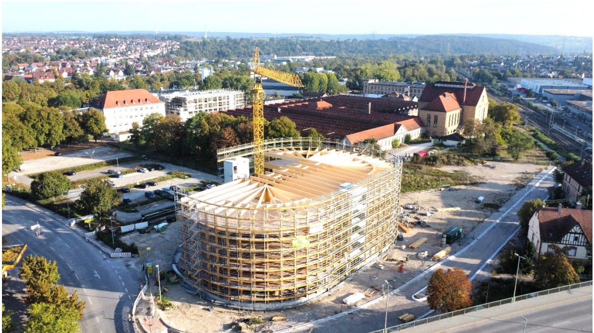
Abbildung 8: Montage des Parkhauses
