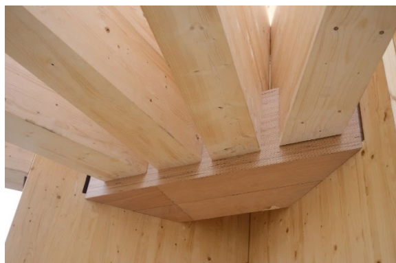
Abbildung 6: Konsolträger aus BauBuche
