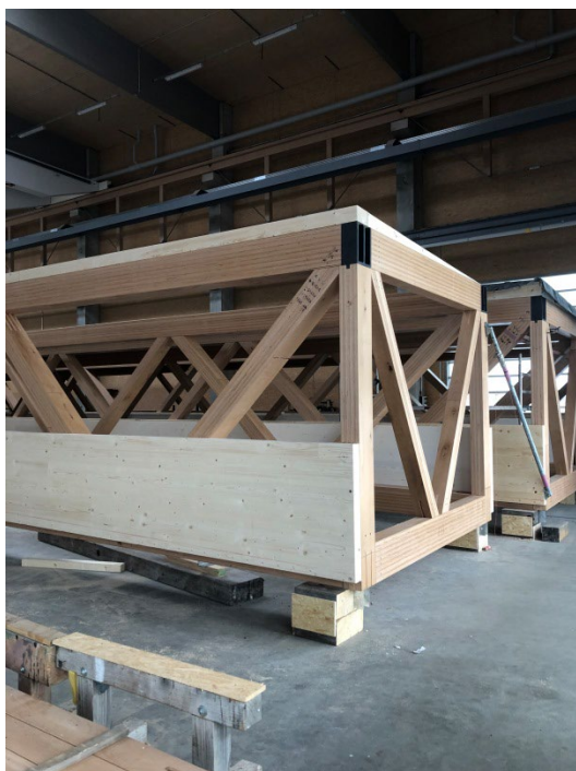
Abbildung 6 (links): Die endmontierten Raumtragwerke erhielten über die gesamte Länge seitlich und als Dach aufgeschraubte BSP-Platten. Die Aufdoppelung auf einem der Obergurte sorgt für das Quergefälle der Dachfläche zur Entwässerung. (Foto: müllerblaustein HolzBauWerke GmbH)
