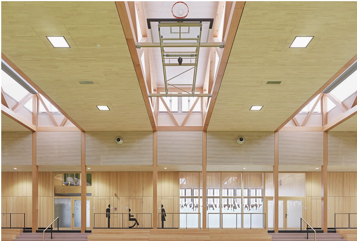
Abbildung 5: Die paarweise zu rund 3,40 m breiten, kastenähnlichen Raumtragwerken verbundenen Fachwerkbinder aus Buchen-Furnierschichtholz überspannen rund 30 m. (Foto: Achim Birnbaum Architektur Fotografie)
