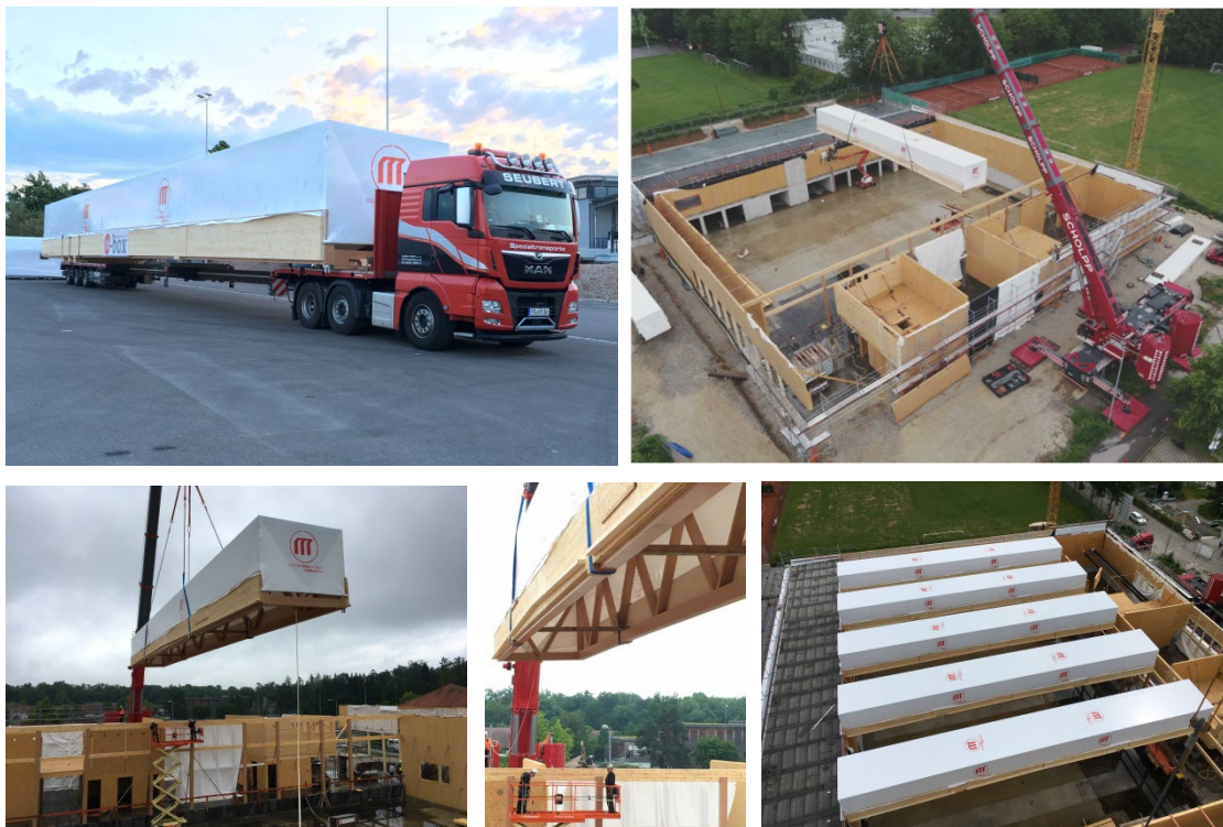
Abbildung 11 bis 15: Die endmontierten Raumtragwerke wiegen jeweils etwa 22 Tonnen. Per Lkw als Sondertransport nach Stuttgart-Waldau gebracht, wurden sie direkt vor Ort mit einem 500 t-Spezialkran eingehoben und angeschlossen. (Fotos: müllerblaustein HolzBauWerke GmbH)
