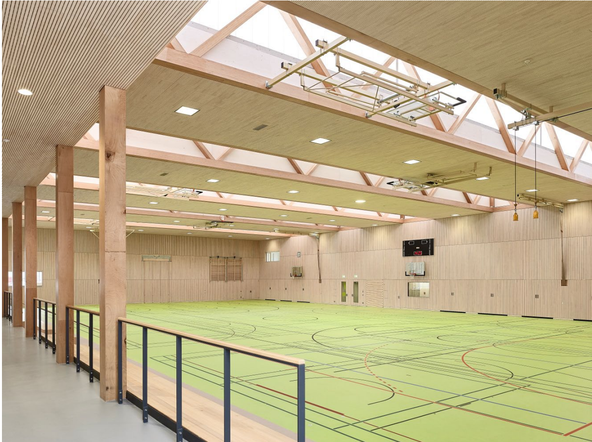
Abbildung 4: Sowohl für die Stützen als auch für das Dachtragwerk kam Buchen-Furnierschichtholz zum Einsatz. Die schlanken Querschnitte, die hellen Farben im Gebäudeinnern und das über die sheddachartigen Dachkonstruktionen einfallende Tageslicht sorgen für eine freundliche Atmosphäre und optimale Bedingungen beim Sport. (Foto: Achim Birnbaum Architektur Fotografie)
