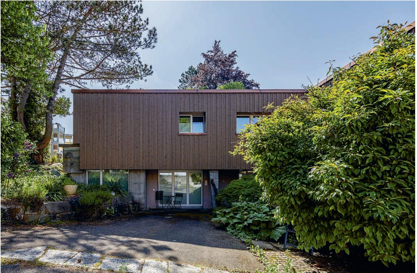
Das Erdgeschoss des Einfamilienhauses erhielt rundum eine Wärmedämmung und eine 3D-Holzverschalung.
