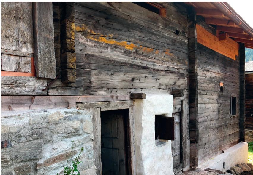
Die Holzbalken des Strickbaus wurden wo nötig ersetzt. Auch das Mauerwerk musste saniert werden.
