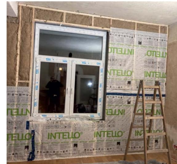
▲ Die neue Innendämmung zur Straßenseite: Zu sehen sind die Hanfdämmung und die Dampfbremse
