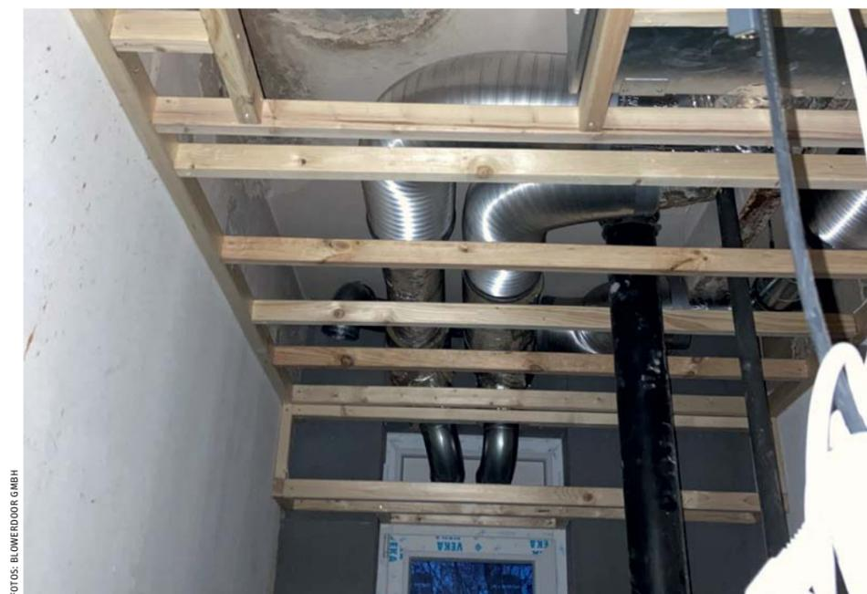
▲ Teilansicht der Lüftungsanlage im Bad. Die Verteilung der Kanäle erfolgt in der abgehängten Decke im Flur
