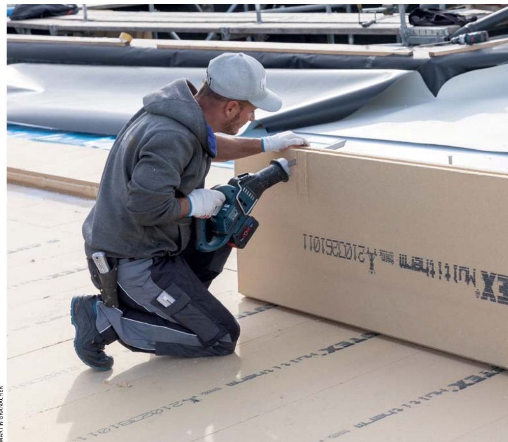
▲ Die Holzfaserdämmplatten lassen sich direkt vor Ort maßgerecht anpassen.
