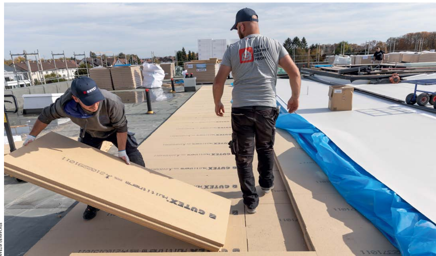
▲ Um eine mittlere Dämmstärke von 15 cm zu erreichen, werden die Gutex Multitherm Platten teils einlagig, in einigen Bereichen zweilagig und an der höchsten Stelle sogar dreilagig verlegt. Nut und Feder-Kanten erleichtern die schnelle Verarbeitung
